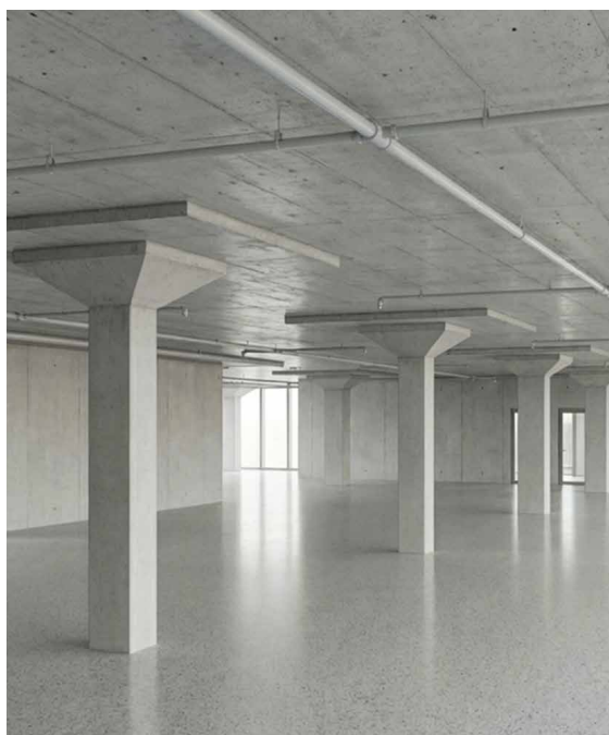
Wankdorfcity 3, Baufeld 6: Leichtere Betondecken dank starken Stützen
